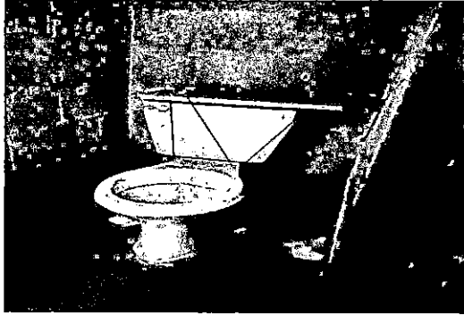
Foto 7: Sustrución de inodoro
