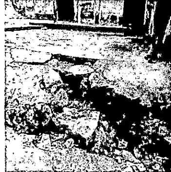
Foto 2: Reparación de piso de torta de concreto
